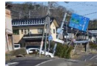
内灘町西荒屋地内（液状化）
